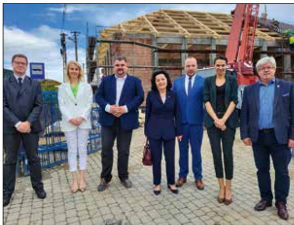
Wizyta na budowie sali gimnastycznej przy Szkole Podstawowej w Jastrzębiu, 2022-07-11
