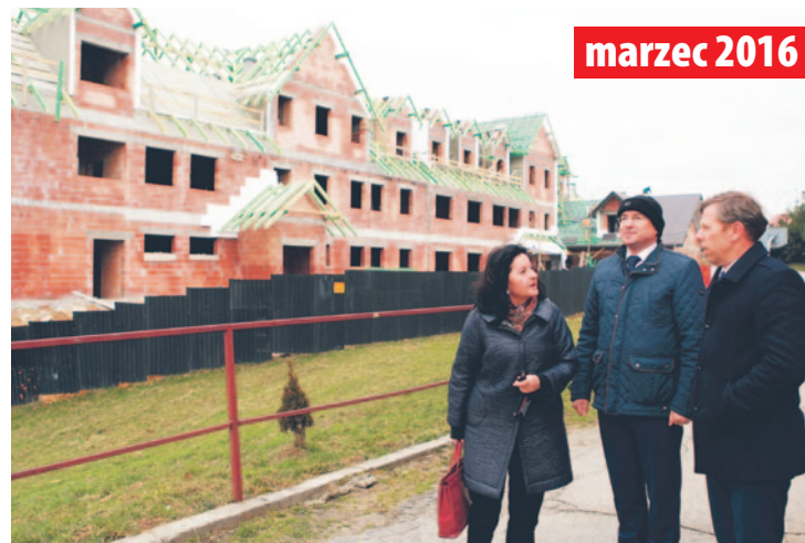
Wizytacja budowy nowej szkoły podstawowej w Kluszkowcach z Wicewojewodą Małopolskim Piotrem Ćwikiem
